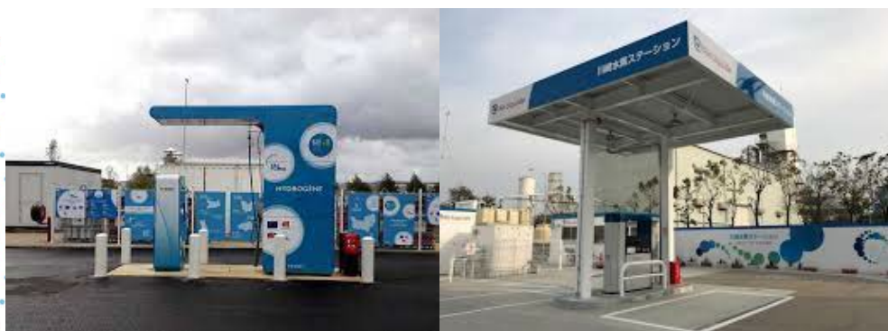
Exemples de barrières de protection
