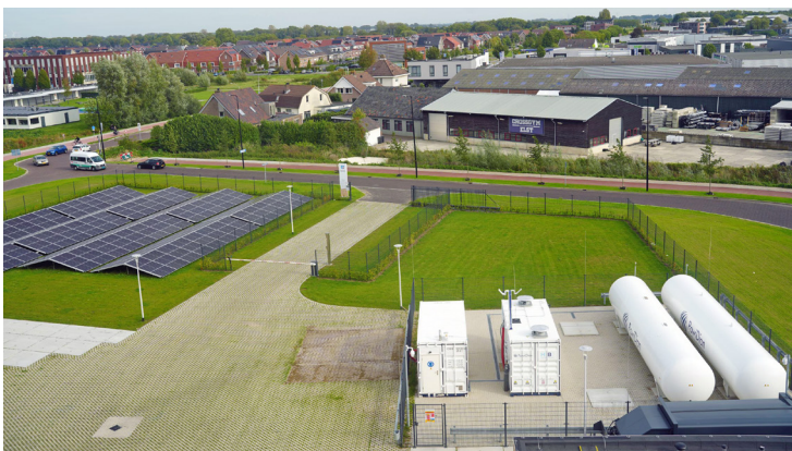
Hôpital Rijnstate (Pays-Bas) : stockage d'énergie avec récupération de chaleur
