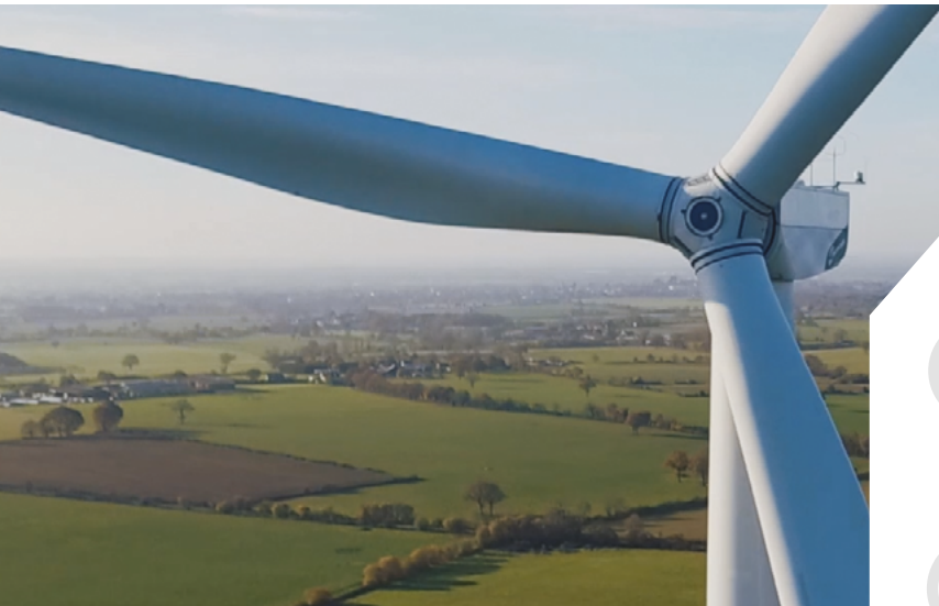
Parc éolien des Touches en Loire-Atlantique (44)
