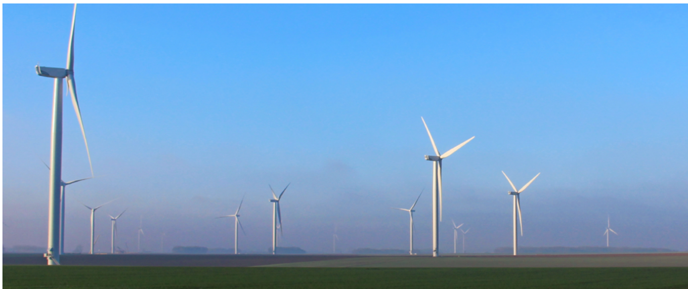
Parc éolien d'Eplèsier dans la Somme (80)
